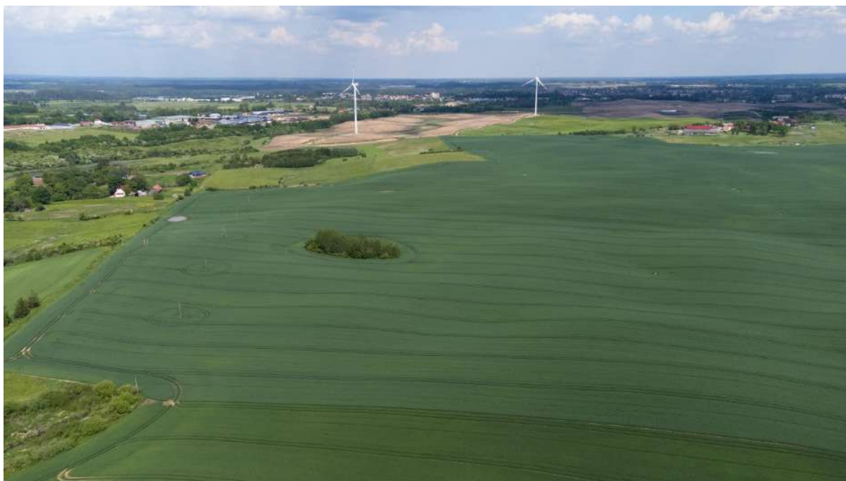
Zdj. Panoramy otoczenia planowanej farmy PV - strona północno wschodnia.
