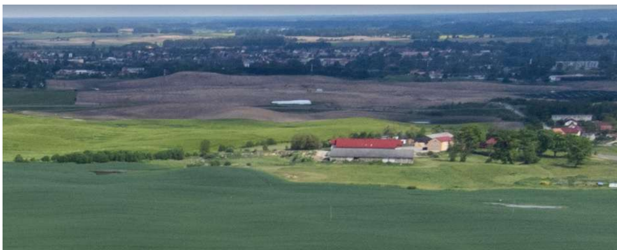
Zdj. Widok terenu inwestycyjnego od północy- widoczna pobliska zabudowa od strony wschodniej
