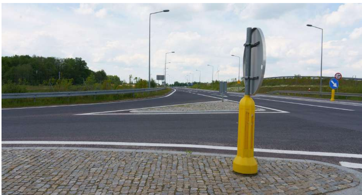
Zdj. Droga rozdzielająca obie farmy PV
