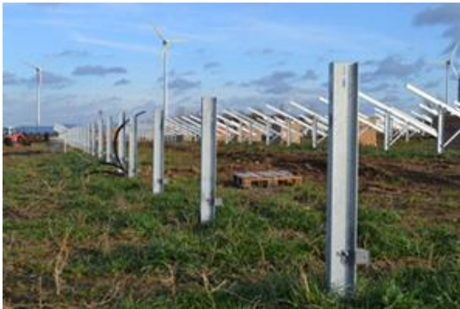
Zdjęcie 6. Profile metalowe: podstawowy element konstrukcji.
