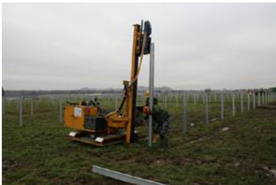
Zdjęcie 7. Montaż profili za pomocą kafara.
