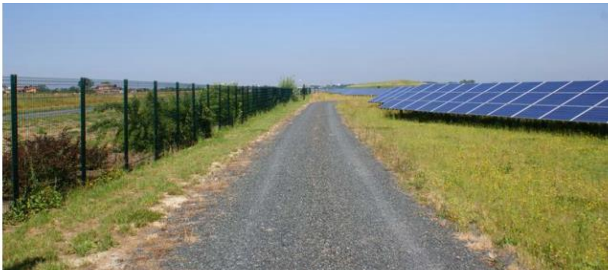
Fot. 1. Widok na przykładowe zastosowanie drogi technologicznej
