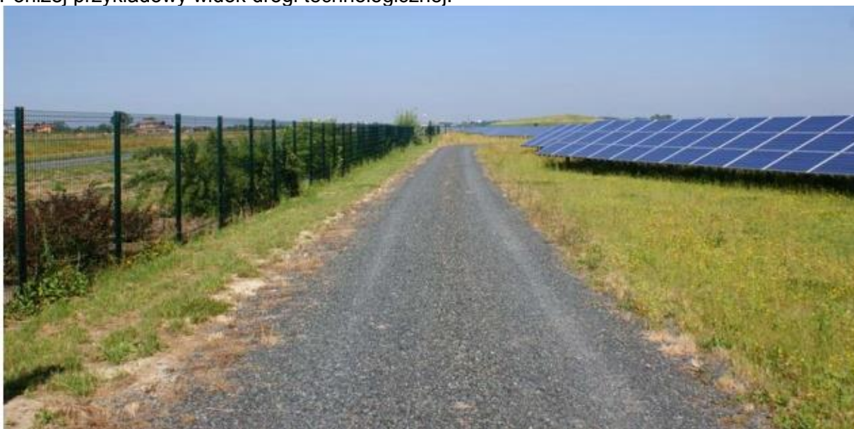
Fot. 1. Widok na przykładowe zastosowanie drogi technologicznej
