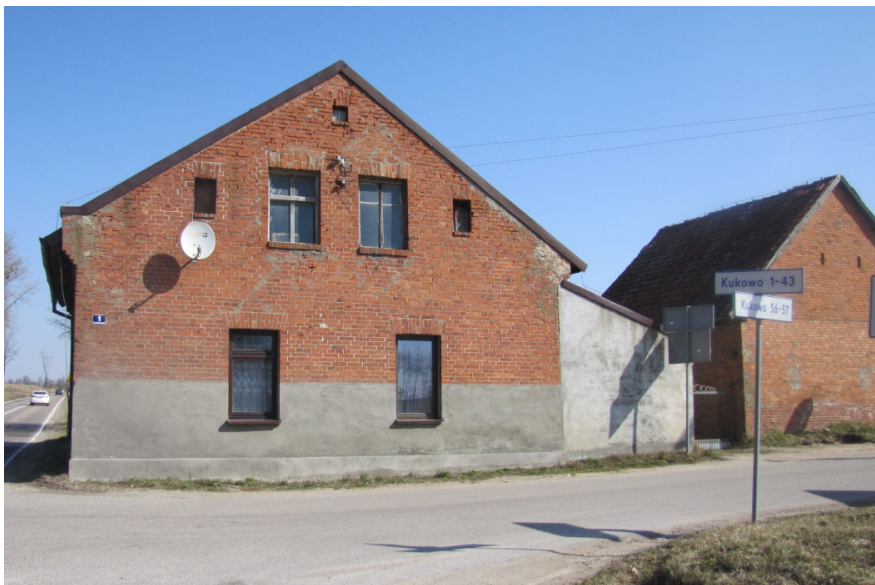
Fot. 1 Budynki przeznaczone do rozbiórki.
