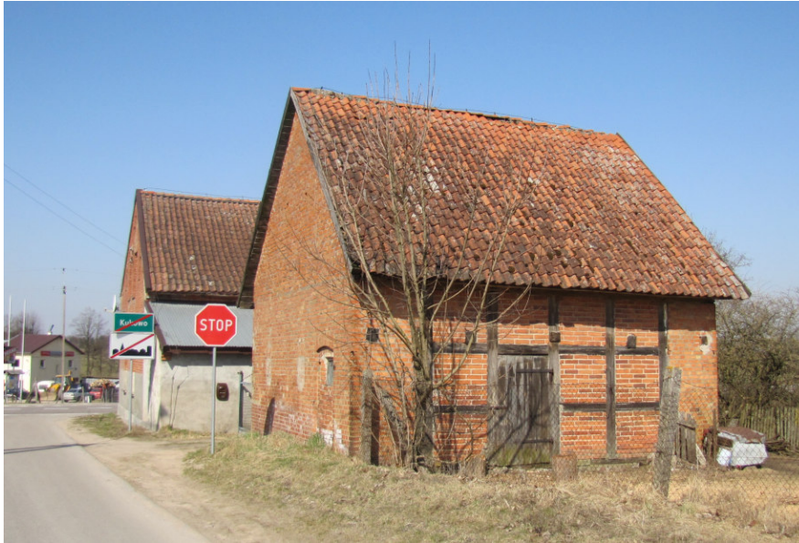
Fot. 2 Budynki przeznaczone do rozbiórki.
