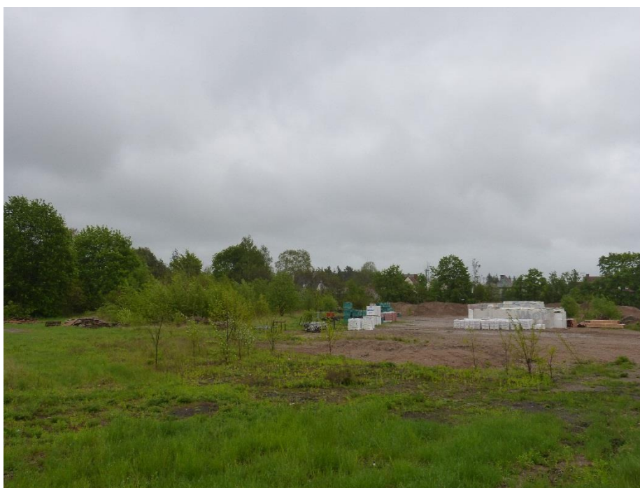
Fot. 2 Wnętrze terenu opracowania ze składowanymi materiałami budowlanymi
