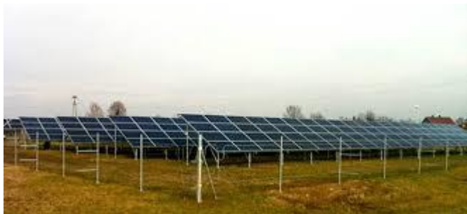
Rysunek 4: Sposób montażu paneli fotowoltaicznych na stelażach wbijanych bezpośrednio do gruntu.
