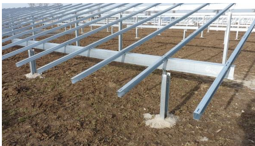
Rysunek 5: Szkielety przed montażem paneli (źródło http://www.chronmyklimat.pl/wideo/energetyka/powstaje-najwieksza-farma-fotowoltaiczna-w-polsce )
