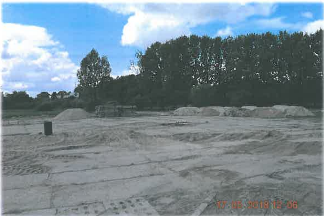
Zdjęcie 2. Plac targowy w czasie przebudowy (maj 2018 roku)
