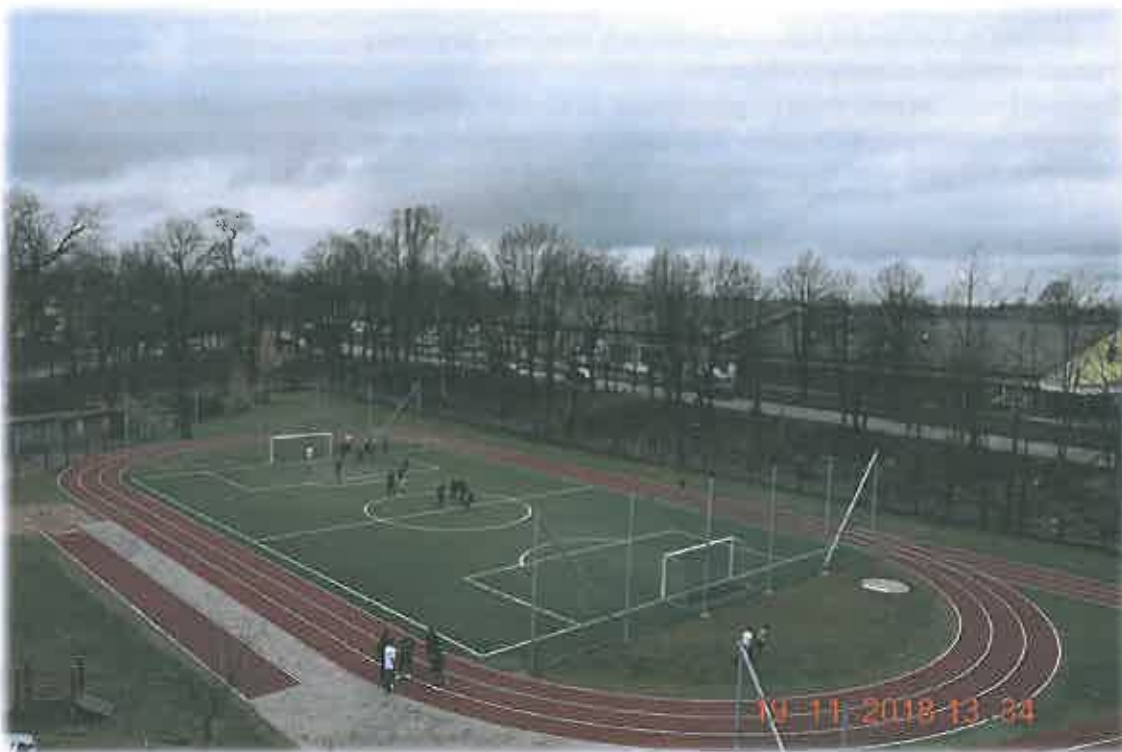
Zdjęcie 5. Przebudowane boiska przy SP3 w Oleku
