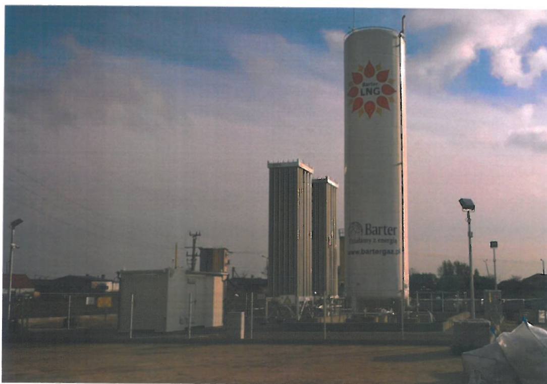
Rys. Stacjonarna stacja regazyfikacji skroplonego gazu ziemnego /LNG/
