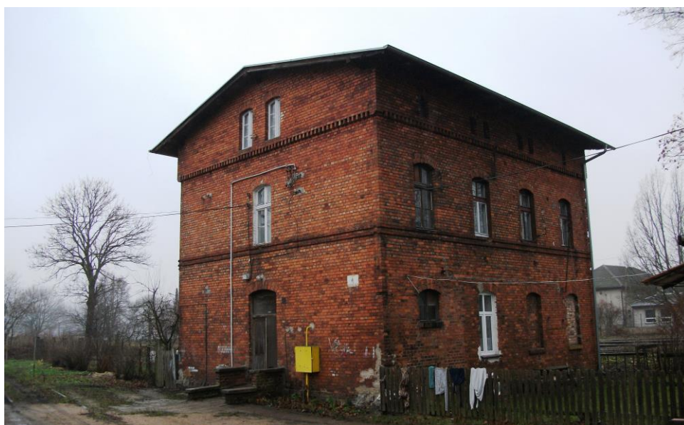
Olecko, ul. Tunelowa 4, dom w zespole stacji kolejowej (wzniesiony ok. 1915 r.)
