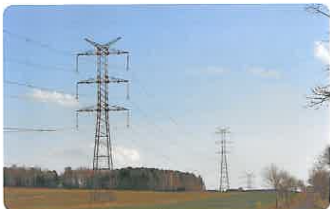
Typowa konstrukcja słupa przelotowego
