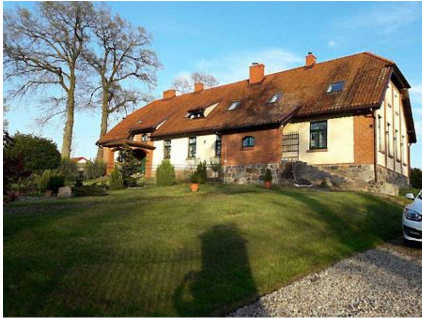
RYS 11. Obszary zabudowane - zabudowa istniejąca - fot własne.
